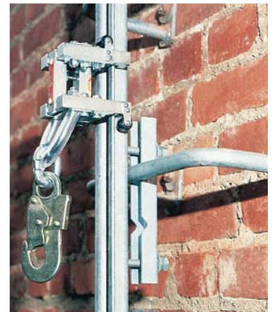
Befestigung der Fallschutzschienen mittig auf den Steigeisen
