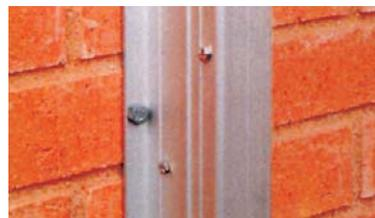
1. Befestigung direkt an der Wand erfolgt durch die vorgebohrten Flansche der Leiter. Abstand zwischen Lochpaaren beträgt ca. 1,45 m, Loch-Ø 8,2 mm.
