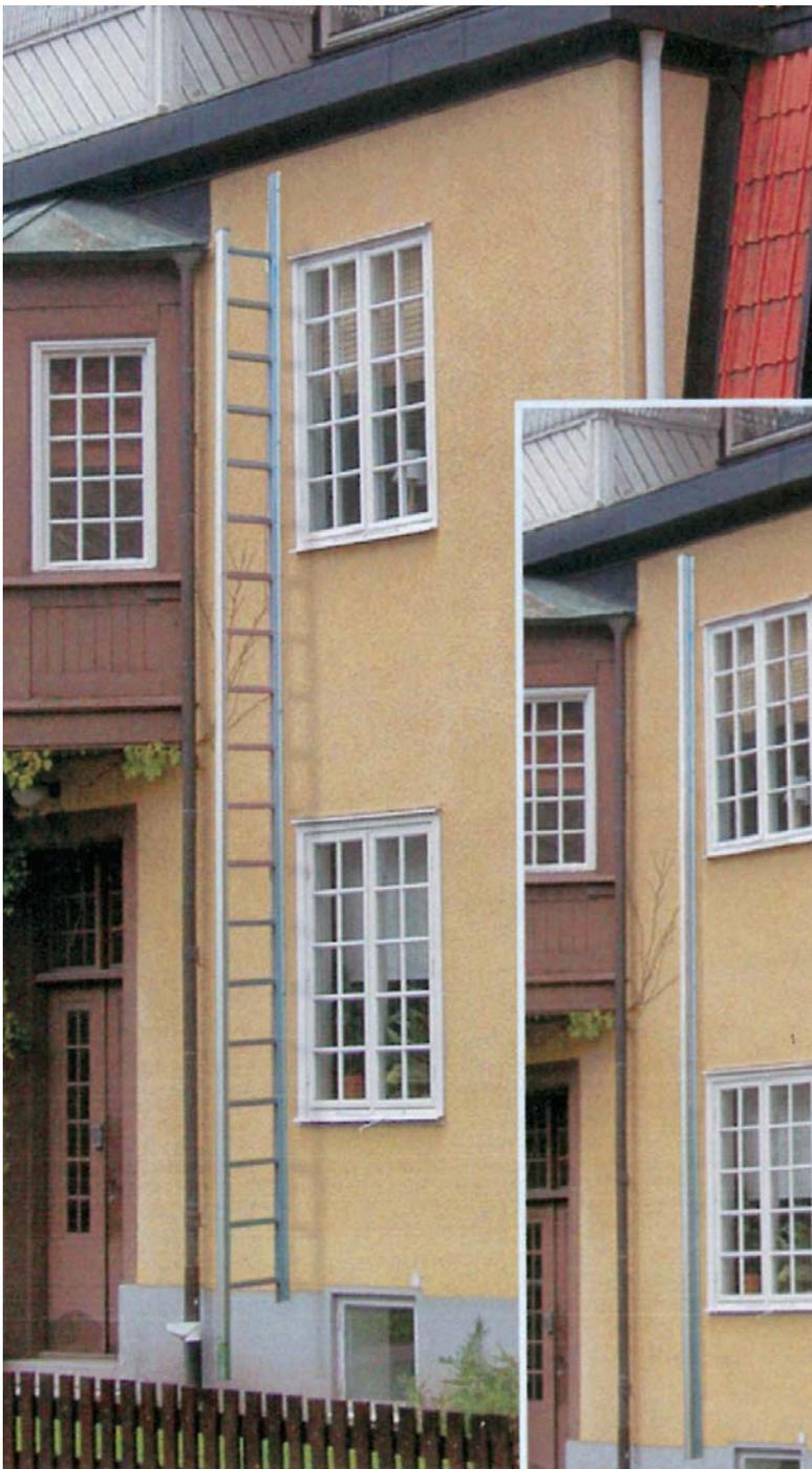
Diese Leiter ist direkt an der Wand montiert, d. h. ohne zusätzliche Wandhalter
