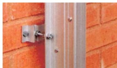
3. Befestigung mit gleichem Wandhalter (Abb. 2) mit 2 beigefügten 50 mm langen Schrauben ergibt einen verstellbaren Wandabstand von 25 – 60 mm.
